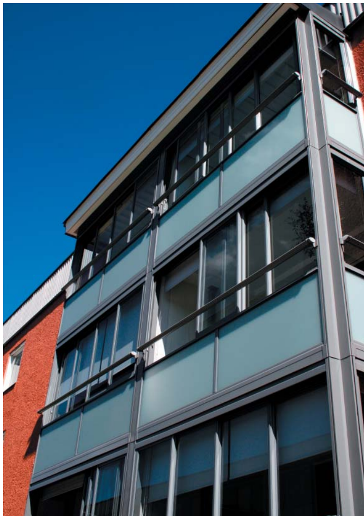
Brf Farnen i Täby låter STARK Fasadenovering bygga ut och glasa in deras över 900 balkonger. Sveriges största balkongutbyggnad avslutas hösten 2009.
